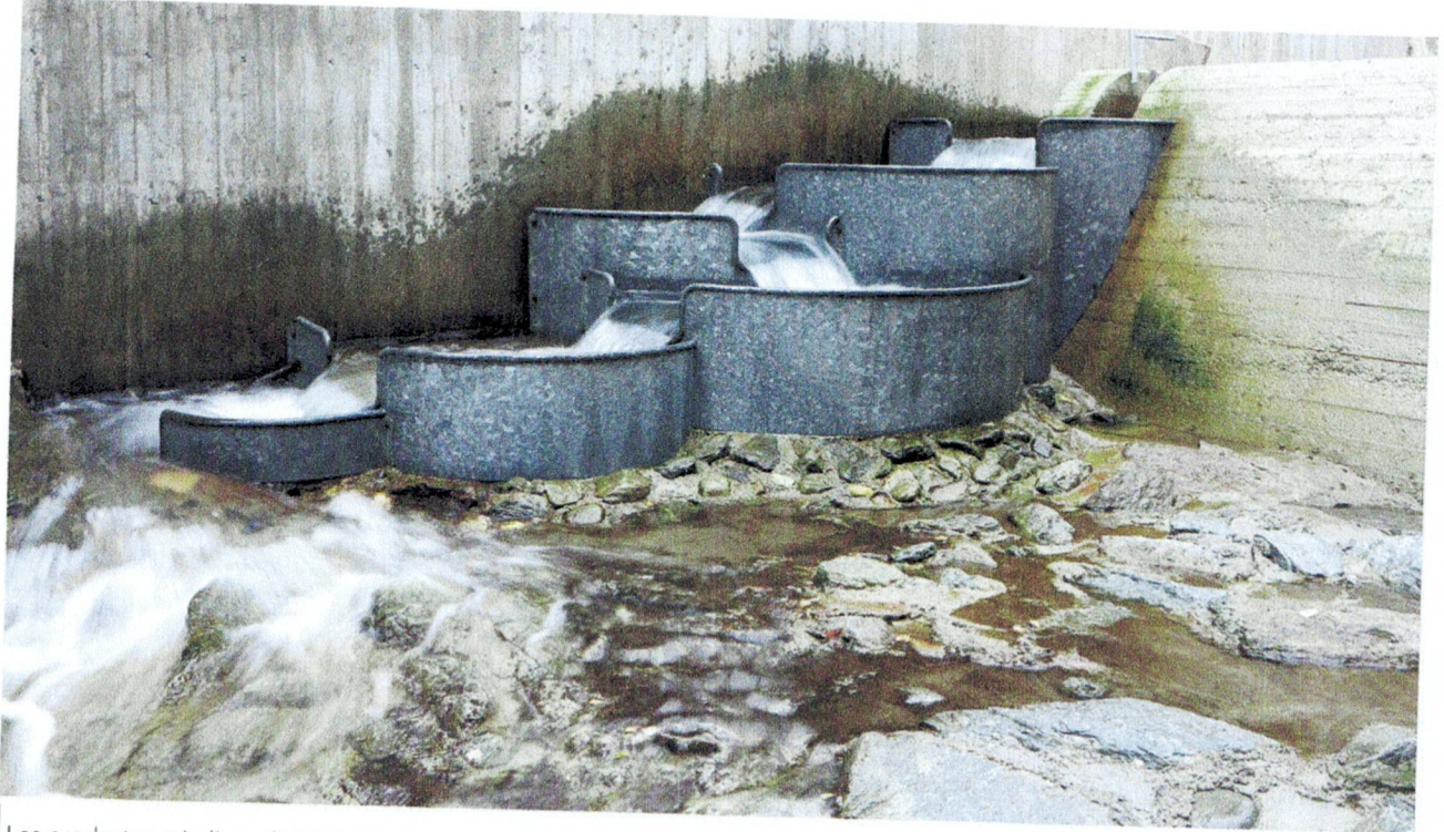
Les producteurs italiens doivent assurer la montaison des poissons mais pas leur dévalaison. En photo, la passe à poissons métallique de la centrale de Planaval, dans la Vallée d'Aoste (1,3 MW). Photo : Fratelli Ronc
